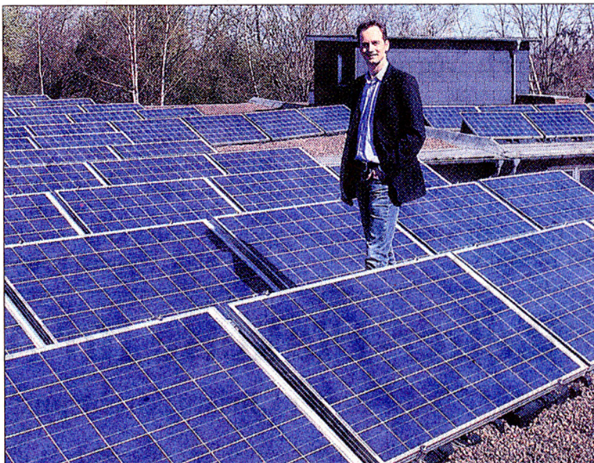
Lohnt sich: Die Firma Sprenker + Gravius hat ihr Dach für die Nutzung von Sonnenenergie aufgerüstet. Foto: Dirk Steinbach
